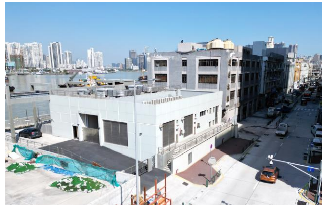
圖 14 內港南雨水泵站
