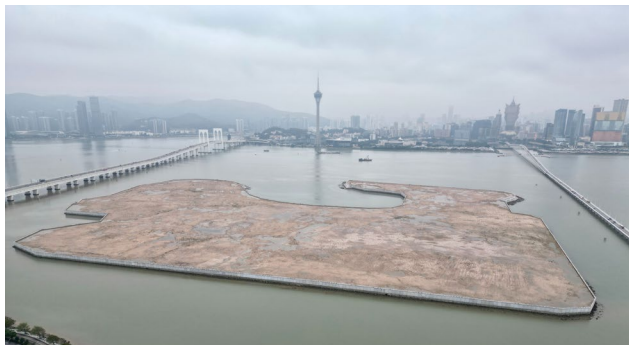
Figura 19: Obra de aterro da Zona C dos Novos Aterros (Fonte: DSOP)
