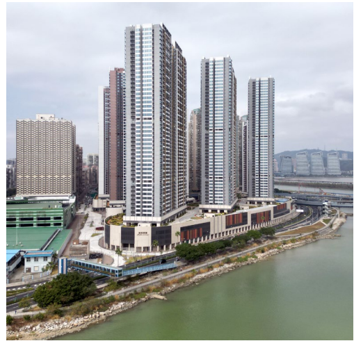
Figura 5: Habitação para alojamento temporário e habitação para troca nos Novos Aterros da Areia Preta
