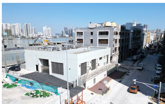
Figura 14: Estação Elevatória de Águas Pluviais no Sul do Porto Interior
